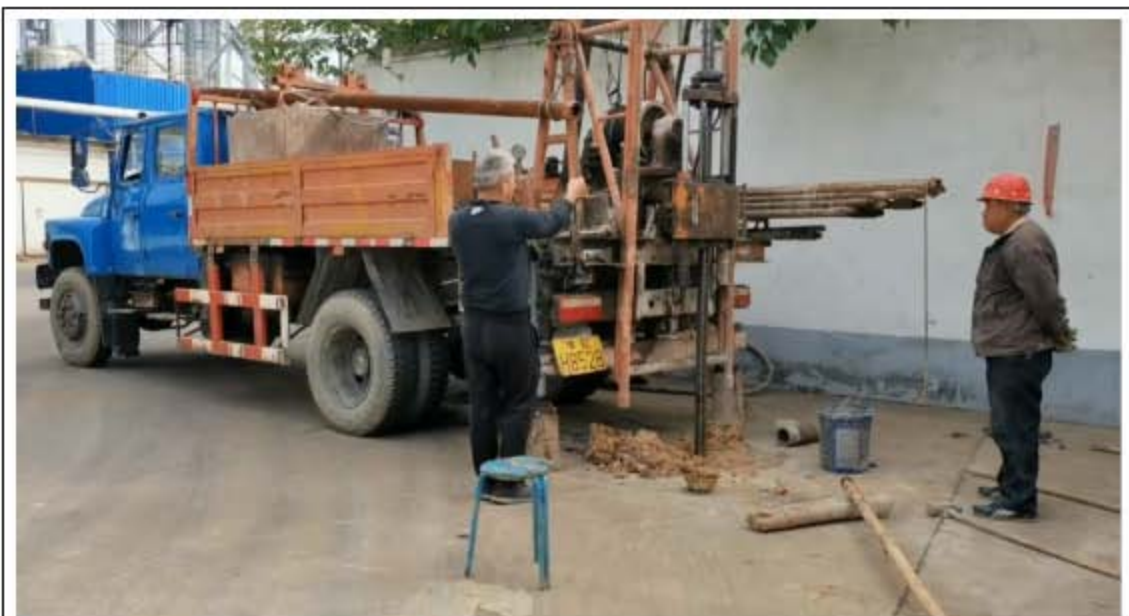
D1 点位打井现状照片
