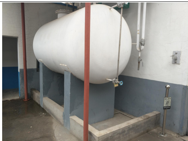
西厂区悬挂储罐
