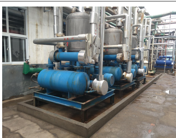
西厂区悬挂储罐
