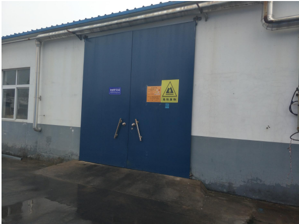
西厂区危废间
